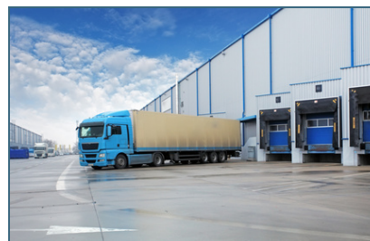
Abb. 6: ...doch der Fahr- und Verladebetrieb ist häufig die größte Lärmquelle.
