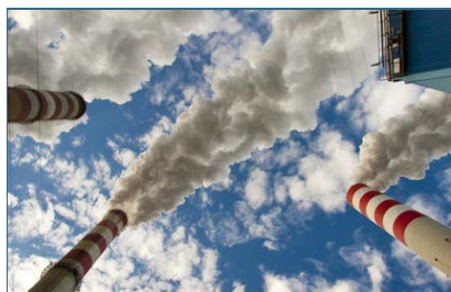
Abb. 4: Technische Anlagen wie Kamine und ...
