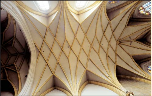
Pfarrkirche von Eggenfelden, Rippengewölbe des Langhauses in sog. Wechselberger-Figuration
