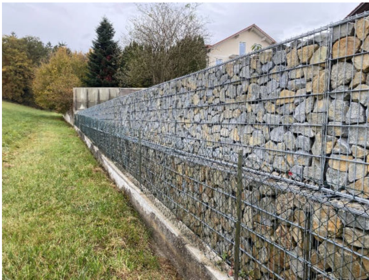
Graben 1: Blickrichtung entgegen Fließrichtung, vorne Gabionenwand, hinten Stützmauer
