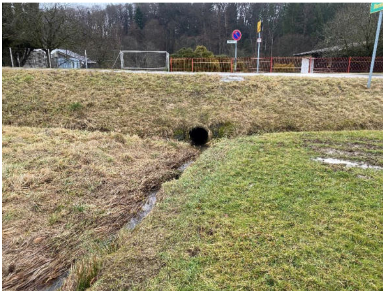
Graben 2: Blickrichtung in Fließrichtung – Durchlass Kreisstraße PAN 10 mit den Straßenseitengräben
