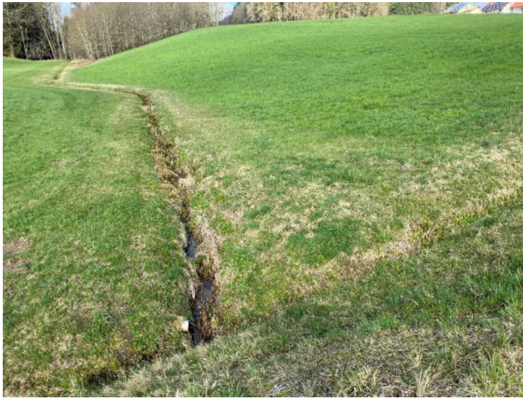
Graben 2: Blickrichtung entgegen Fließrichtung
