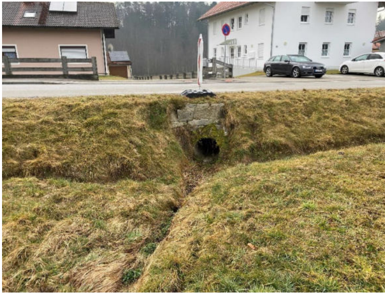
Graben 1: Blickrichtung in Fließrichtung beim Straßendurchlass, beidseitig mit Straßenentwässerung
