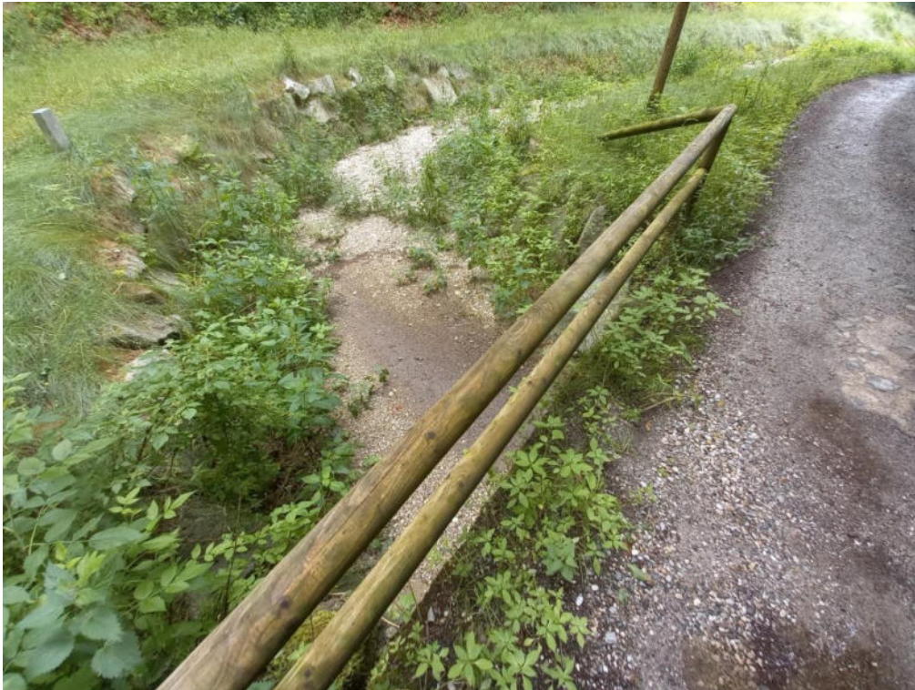
Abbildung 1. Beginn des Provisoriums am 23.06.2021 aufgenommen mit gut ersichtlicher Ablagerung von Feinsediment in einer Sohlenenke im direkten Quellfassungsbereich durch Versickerung entstanden.
