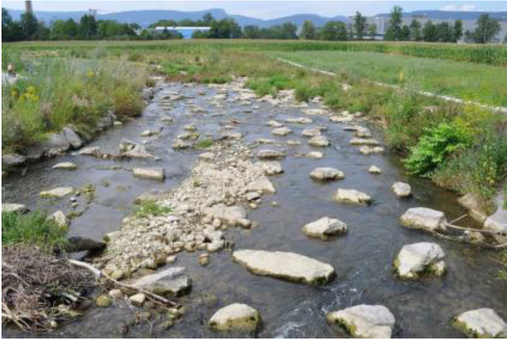
Abbildung 5 Beispiel - kleine unstrukturierte Blockrampe, aus aufgelöste unstrukturierte Blockrampen – Eine Praxisanleitung (Zürich – Dr. Robert Boes, 2017)
