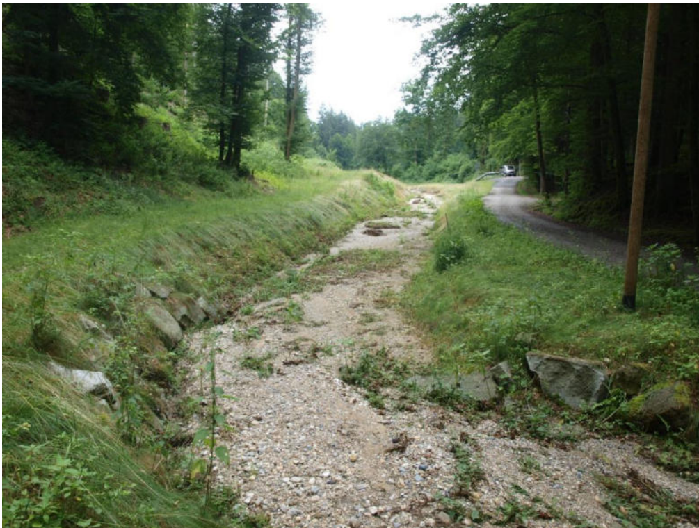
Abbildung 2. unmittelbar an den Bereich aus Abb. 1. angrenzender Verlauf des provisorischen Gerinnes, bereits mit fluvial eingebrachter Substratauflage über dem Vlies bzw. Granitsteinlage.
