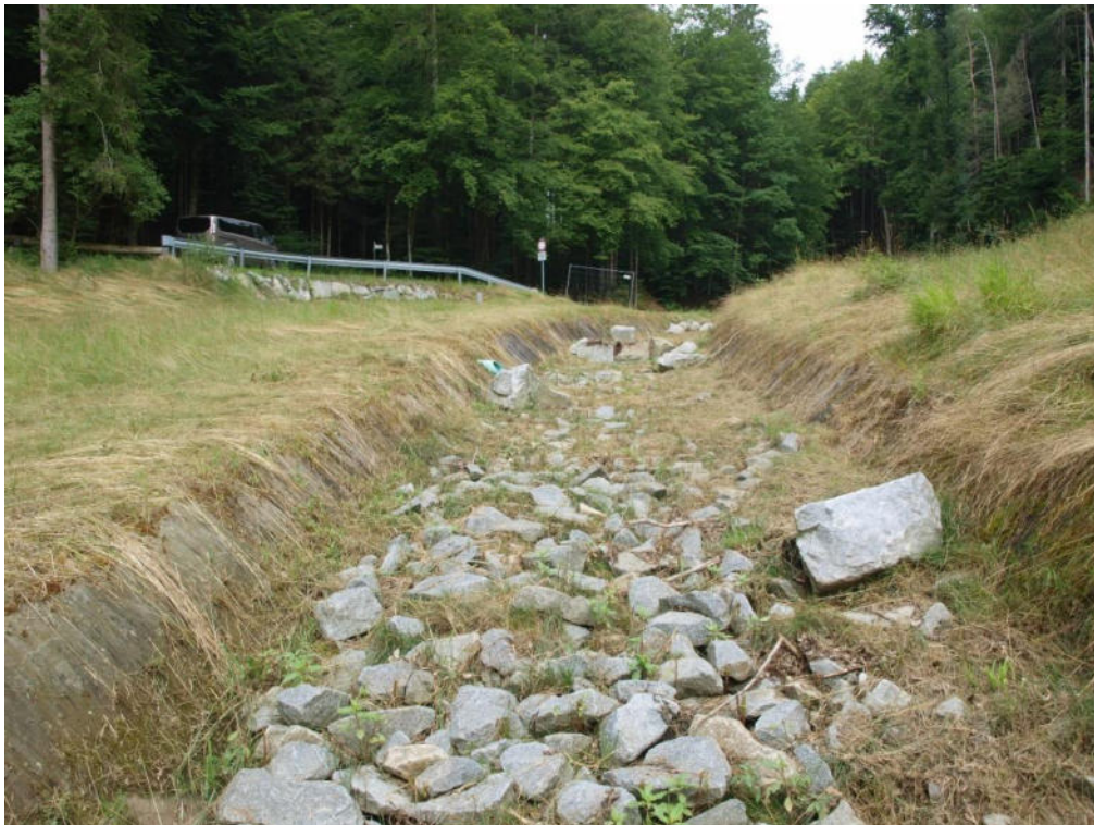
Abbildung 3. Provisorisches Bachbett gesichert mit Vlies und Granitsteinpackung
