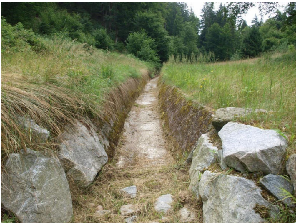
Abbildung 4. Noch vorhandener Abschnitt des Gewässertroges aus Beton/Natursteinmauerwerk
