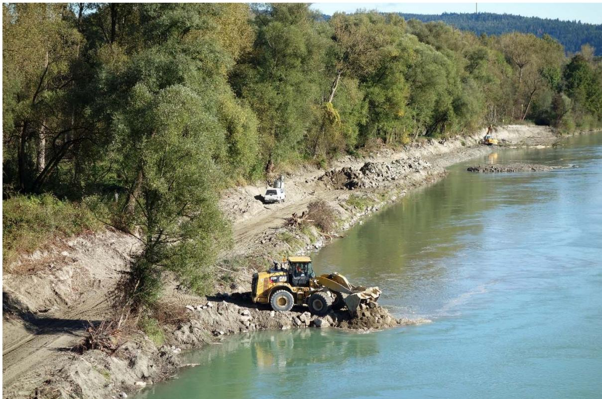
Abbildung 30: Herstellung des Uferrückbaus in der Stauwurzel Ering im Herbst 2016.
