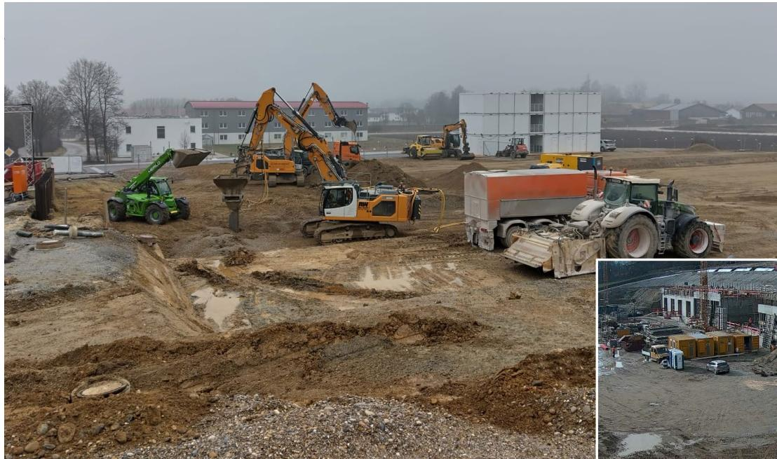
Nach dem Fertigstellen der ersten Wände vom Logistikgebäude werden nun die ersten Decken betoniert. Der Kopfbalken im Bereich der östl. Bohrfahlwand ist bereits fertig. Der Kopfbalken im Bereich der westl. Bohrfahlwand wird gerade hergestellt.
