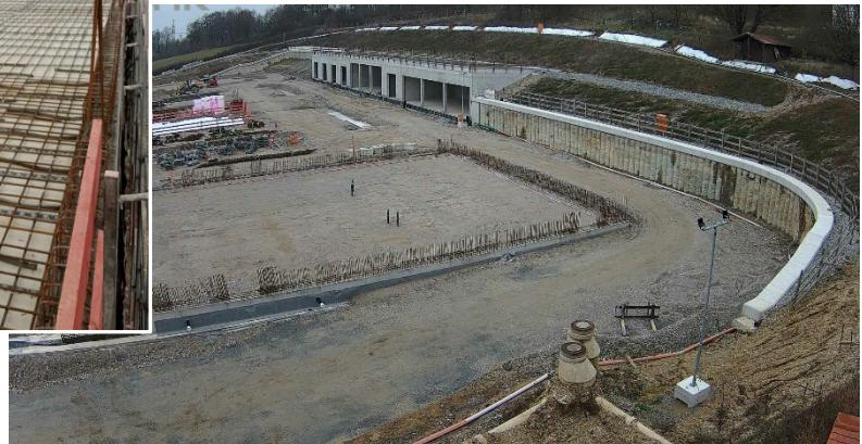
Beim Baufeld der Werksatt\_04 im unterkellerten Bereich wurde die Bodenplatte und ein Teil der Außen- und Innenwände errichtet. Im unterkellerten Bereich der Werkstatt\_03 wurden die Drainagen verlegt und die Sauberkeitschicht eingebracht. Die Gruben für die spätere Werkstattausstattung, werden hergestellt.
