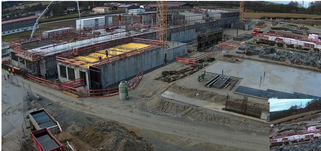
Im unterkellerten Bereich der Werkstatt\_04 wurde die Schalung für die Decke verlegt und im Bereich der Bodenplatte mit dem Verlegen der Abdichtung begonnen.
