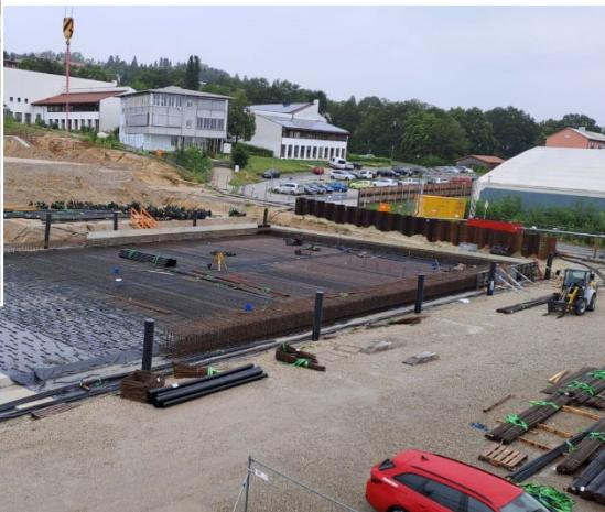
Das Planum der Werkhalle\_04 ist fertig gestellt. Übergabe an die ausführende Firma ist für KW31 angedacht. Aktuell wird im Bereich der Werkhalle\_03 das Planum mit den erforderlichen Gruben hergestellt.
