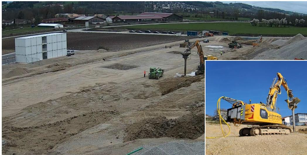
Aktuell erfolgt die Bodenstabilisierung mittels Rüttelstopfsäulen der unterkellerten Bereiche der Werkstätten. Die Stabilisierung im Bereich des ersten Kranstellplatzes ist abgeschlossen.
