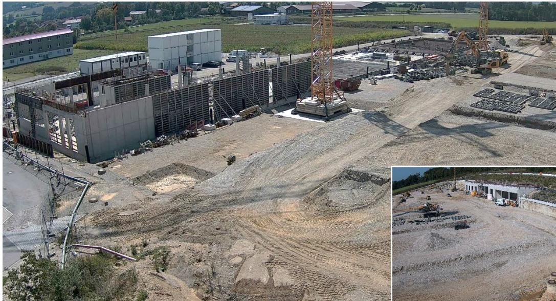
Die Übergabe des Baufelds der Werkhalle\_04 ist an die Baufirma erfolgt. Im Bereich der Werkhalle\_03 wurde das Planum mit den erforderlichen Gruben hergestellt. Aktuell erfolgt die Bodenstabilisierung mittels Rüttelstopfsäulen im Bereich der Werkhalle\_02.
