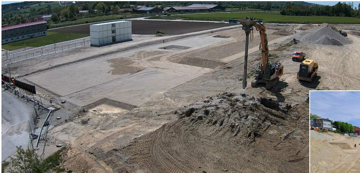
Die Betonarbeiten im Baufeld des Logistikgebäudes sind abgeschlossen. Derzeit werden die Abdicht- und Dämmarbeiten ausgeführt. Die Schal- und Betonarbeiten im Bereich des Kopfbalken der westlichen Bohrpfahlwand sind in vollem Gange.
