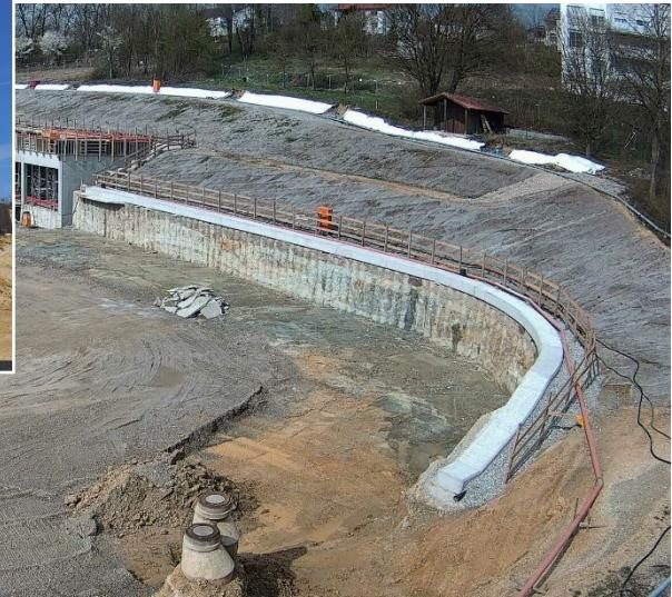
Die letzten Wände vom Logistikgebäude werden betoniert. Die Schal- und Betonarbeiten im Bereich des Kopfbalken der westlichen Bohrpfahlwand sind in vollem Gange.
