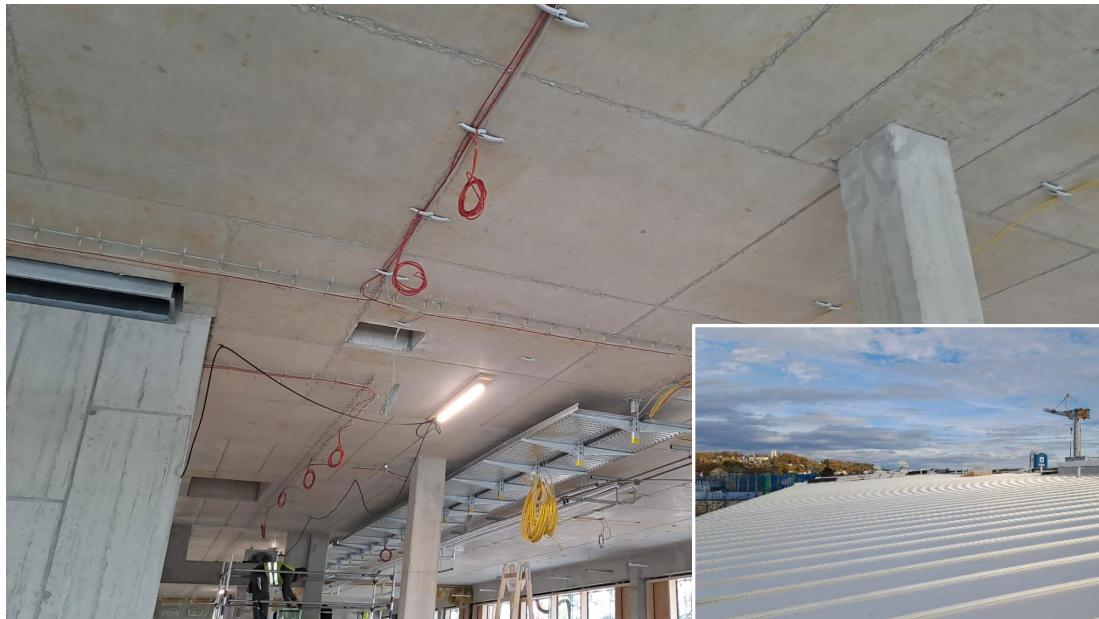
Im Baufeld der Werkstätten sind die Betonarbeiten abgeschlossen. Bei der Werkstatt\_04 erfolgt aktuell die Dacheindeckung mittels Sandwichpaneele. Die komplette Dachkonstruktion der Werkstatt\_03 ist errichtet.
