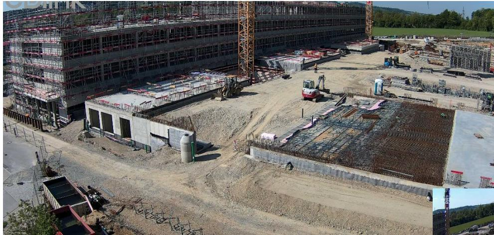
Im Baufeld der Werkstatt\_03 und \_04 wurde hinter dem unterkellerten Bereich hinterfüllt.
