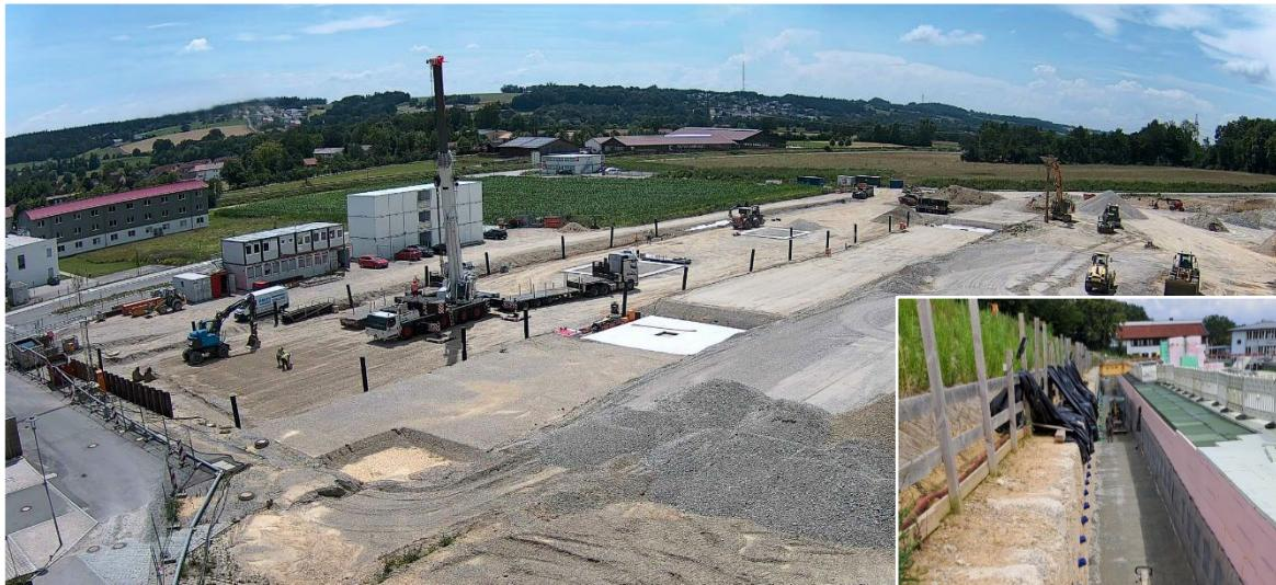
Nach wie vor wir der Arbeitsraum zwischen Logistikgebäude und Bohrpahlwand verfüllt.
