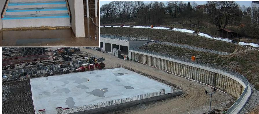
Im Bereich der Werkstatt\_03 wurde im unterkellerten Bereich die Decke über E0 betoniert.
