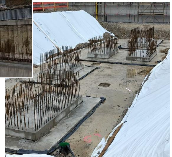
Beim Baufeld der Werksatt\_04 wurden im unterkellerten Bereich weitere Außen- und Innenwände errichtet. Ein Teil der Sauberkeitsschicht im Bereich der Bodenplatte wurde betoniert. In der Werkstatt\_03 wurden im unterkellerten Bereich die Sauberkeitsschicht, die Abdichtung sowie die erste Lage der Bewährung verlegt. Die Bodenplatten der Gruben für z. B. Kfz-Hebe-bühnen wurden hergestellt. In der Werkstatt\_02 wurden im unterkellerten Bereich die Drainagen verlegt.
