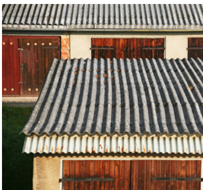
Abb. 15: In der Nähe von intakten Asbestdächern ist keine zusätzliche Faserbelastung messbar. Daher können unbeschädigte Dächer erhalten bleiben, ebenso gut erhaltene Fassadenschindeln.
