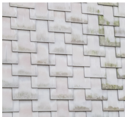
Abb. 15: In der Nähe von intakten Asbestdächern ist keine zusätzliche Faserbelastung messbar. Daher können unbeschädigte Dächer erhalten bleiben, ebenso gut erhaltene Fassadenschindeln.
