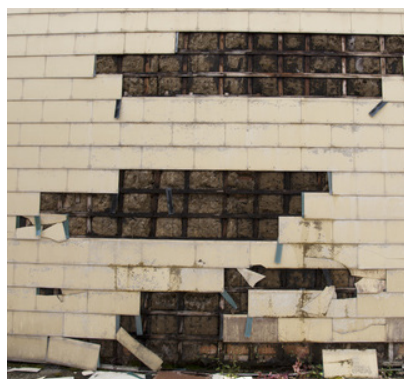
Abb. 14: Beschädigte Dachplatten sollten bald ausgetauscht werden, ebenso kaputte Fassadenschindeln und defekte Bodenplatten.
