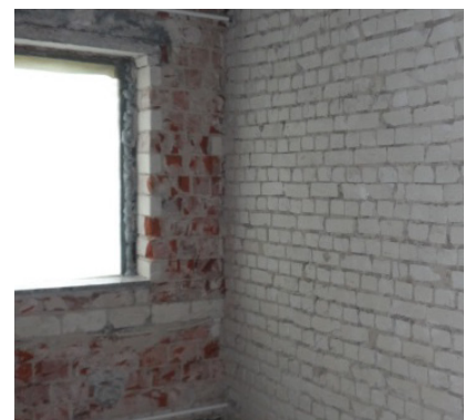
Abb. 16: Wand nach der Entfernung des asbesthaltigen Putzes
