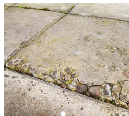
Abb. 14: Beschädigte Dachplatten sollten bald ausgetauscht werden, ebenso kaputte Fassadenschindeln und defekte Bodenplatten.
