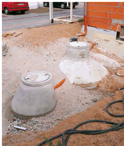
Abb.: Regenwasserspeicher kombiniert mit Versickerung.
