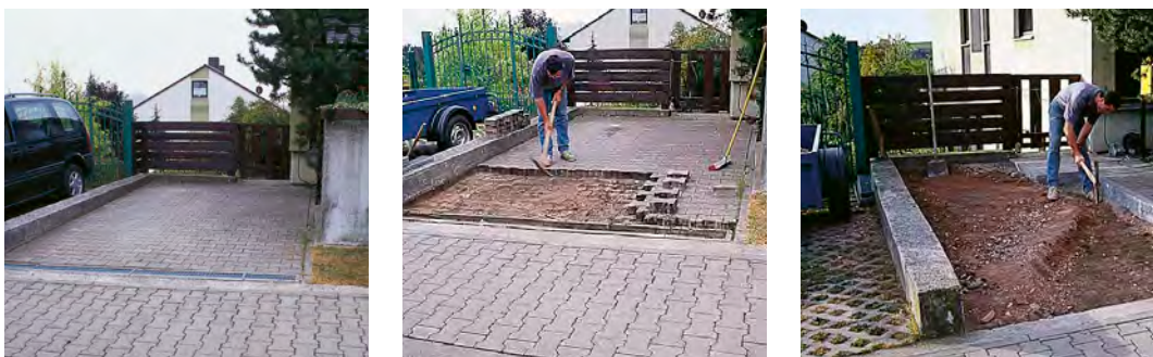
Abb. links: Befestigte Fläche.
