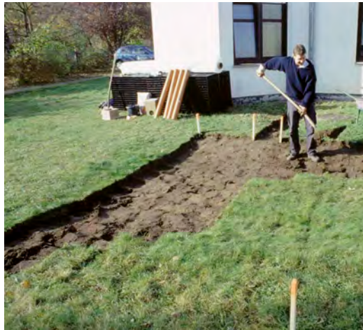
Abb. links: Abstecken der Baugrube.
