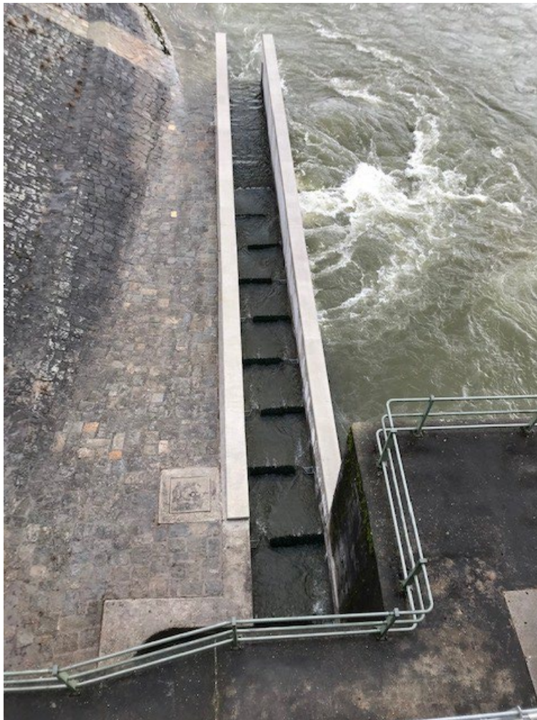
Abbildung 4: Adapterter Beckenpass der historischen Fischaufstiegsanlage
