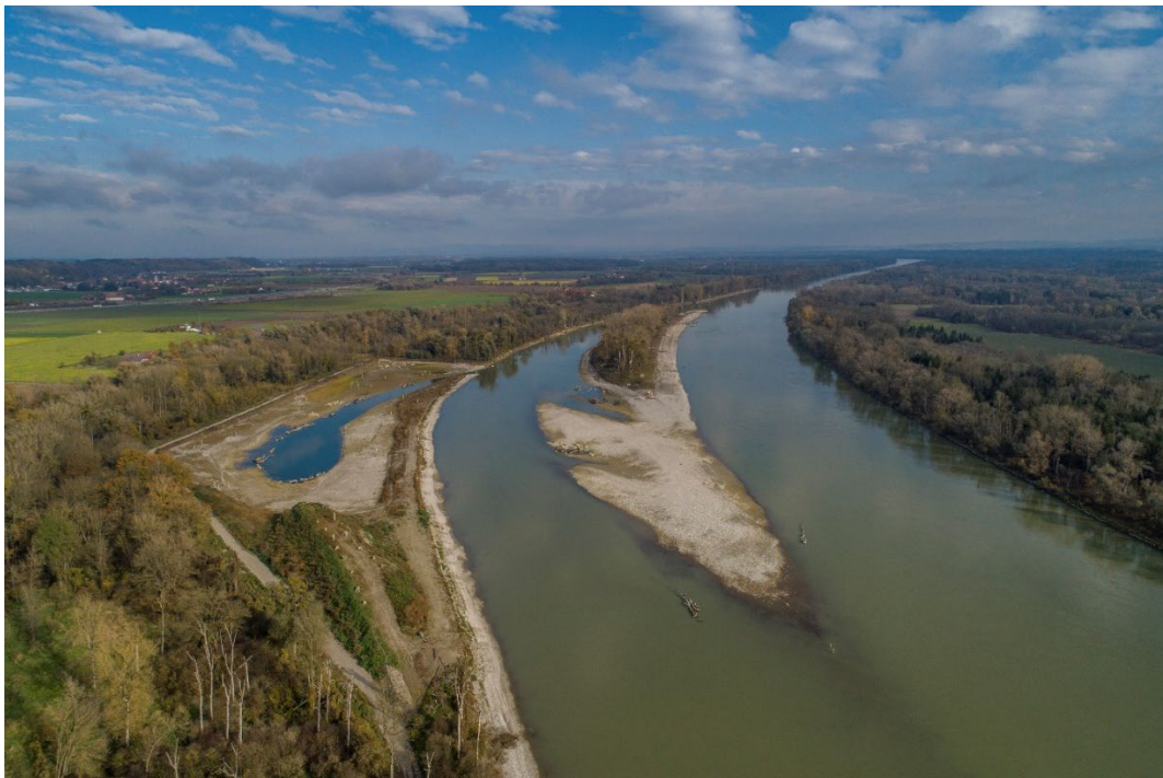
Abbildung 8: Übersichtsfoto des Insel-Nebenarmsystem 2019 nach Fertigstellung (© Lorenz)
