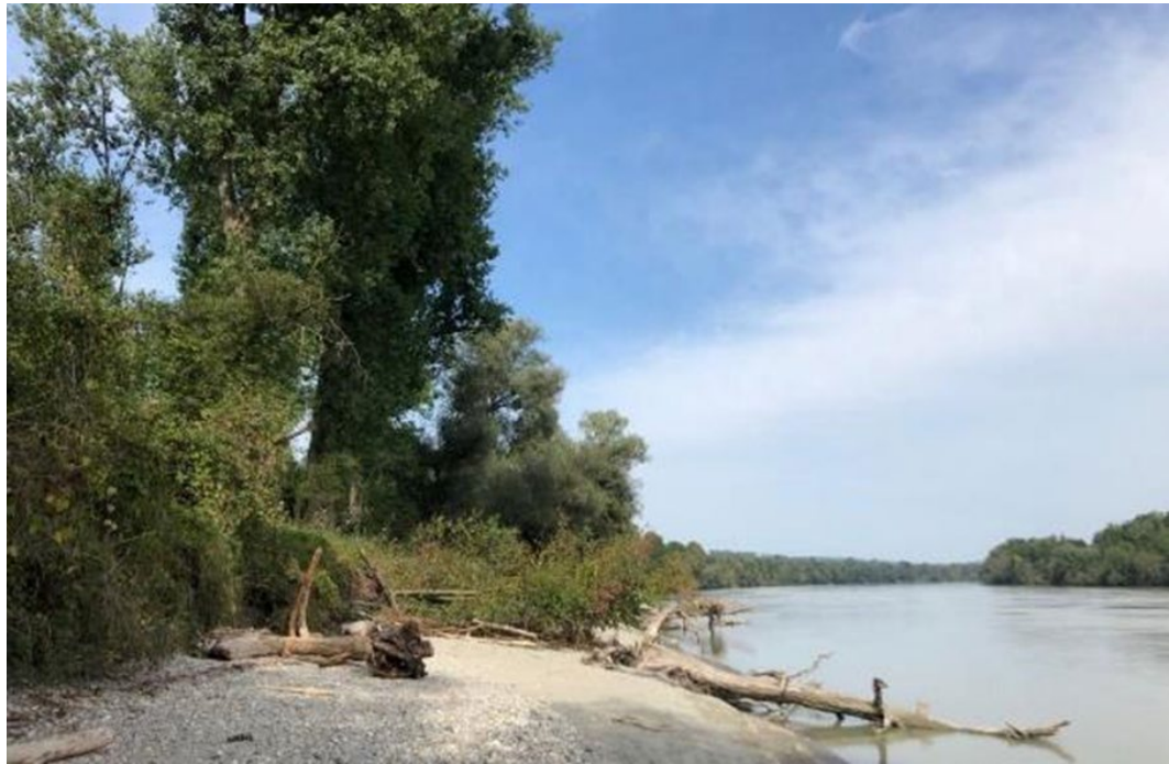
Abbildung 5: Linkes Ufer in der Stauwurzel des Innkraftwerks Ering-Frauenstein nach dem Uferrückbau
