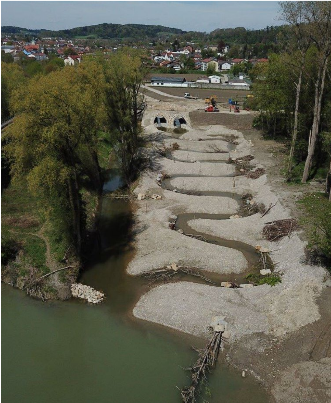
Abbildung 10: Revitalisierung des Mündungsabschnittes des Simbach Bauzustand Mai 2021 nach der Flutung (© ezb – TB Zauner GmbH)
