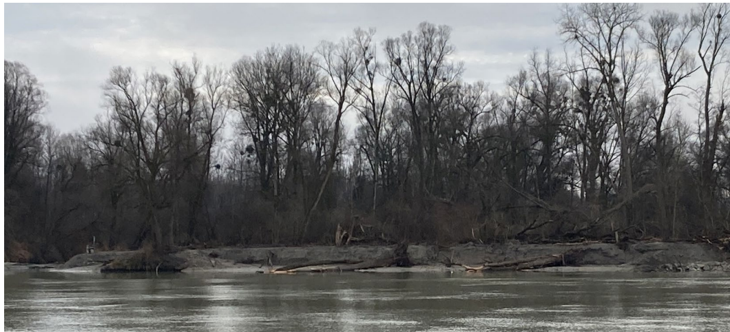
Abbildung 12: Rechtsufriger Uferrückbauabschnitt flussauf der Mattigmündung (Blick vom linken Innufer)
