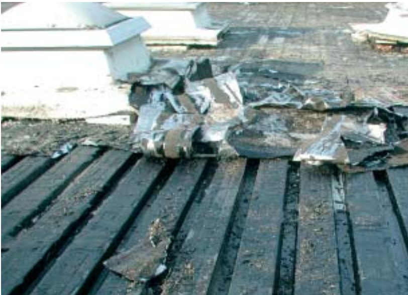
Dachpappe aufgeklebt auf Trapezblech
