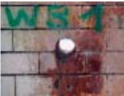
durchkernte Zwischenmauer
