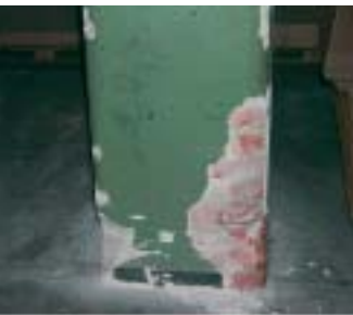
Pfeiler mit grüner Wandfarbe
