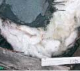
Dachaufbau mit weißer KMF-Wolle
