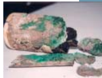
Bohrkern eines Hallenbodens mit grünen Chromverunreinigungen
