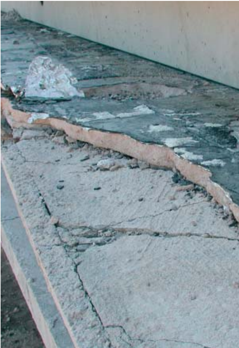
Schwarzanstrich und verklebte Sperrbahn (alukaschiert)
