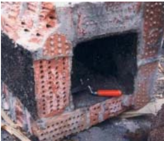
Querschnitt durch einen Kamin
