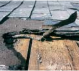
Dachpappe auf Holzschalung
