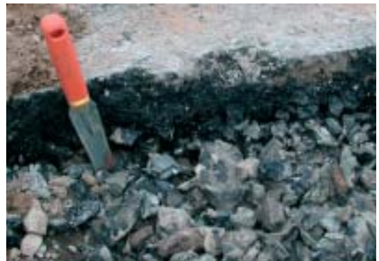
Anschnitt einer Schwarzdecke
