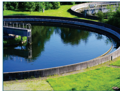
Abb. 3: In Kläranlagen werden Kohlenhydrate, Fette und Eiweiße abgebaut. Ausgefauter Klärschlamm kann mehr oder weniger stark riechen.
