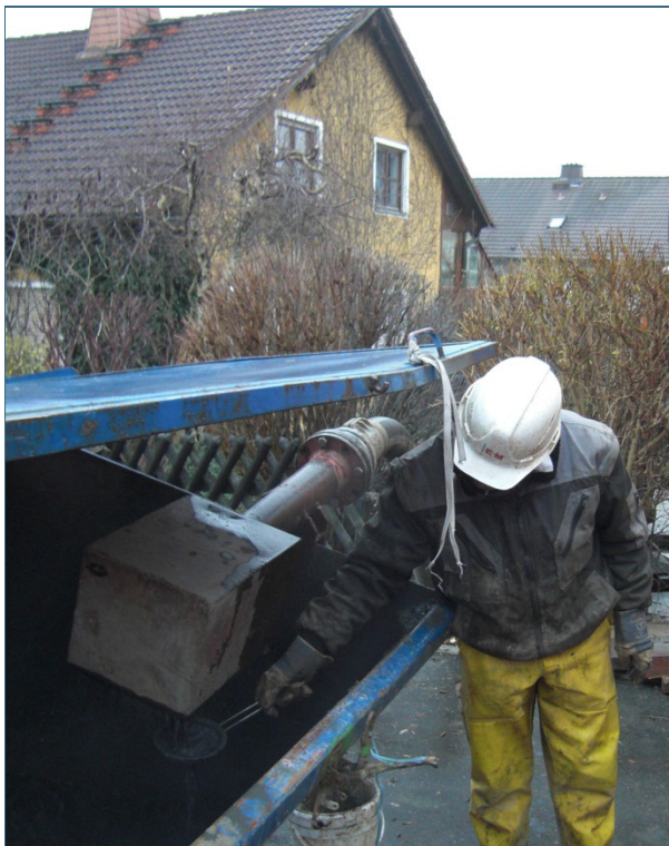
Abb. 7: Um die Bohrung zu dokumentieren, werden laufend Proben entnommen.
